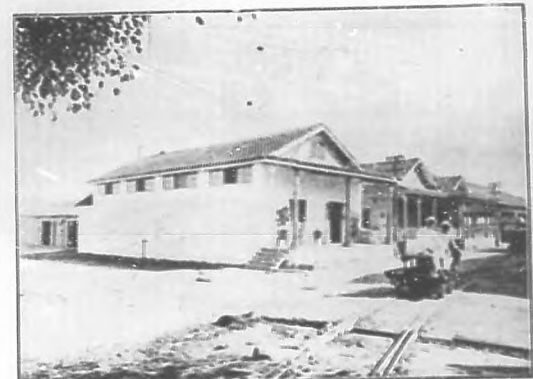
Vista exterior de la panadería y casa de empleados en el Departamento Comercial del Central "Chaparra".
